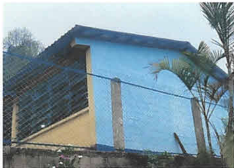
Foto 6: COLOCACION DE MALLA EN MURO EXTERIOR DE 16 ML.
