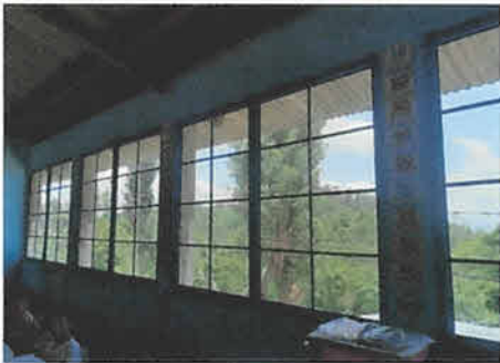
Foto 5: SUSTITUCIÓN DE VENTANA TRADICIONAL POR VENTANA ABATIBLE DE 1.45X1.80 M2.
