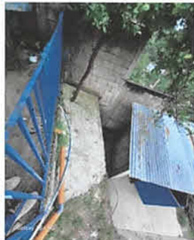
Foto 4: REPARACION DE MURO PERIMETRAL EXTERIOR DE 2X2 M2.
