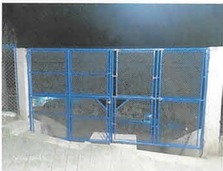
Foto 3: PINTURA Y CAMBIO DE MALLA DE 2 PORTONES.
