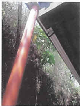
Foto 2: COLOCACION DE 22 ML DE CANAL ALUCIN.
