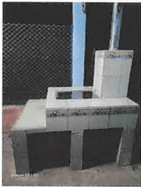
Foto1: SUSTITUCIÓN DE COCINA RURAL POR HORNILLA CON PLANCHA Y CHIMENEA.
